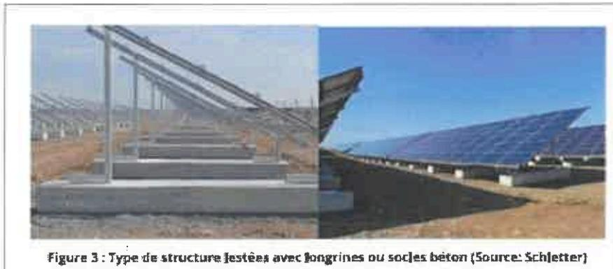
Figure 3 : Type de structure lestées avec longrines ou socles béton (Source: Schletter)
